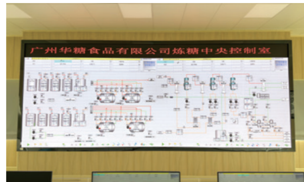
华糖公司炼糖中控系统管控界面
